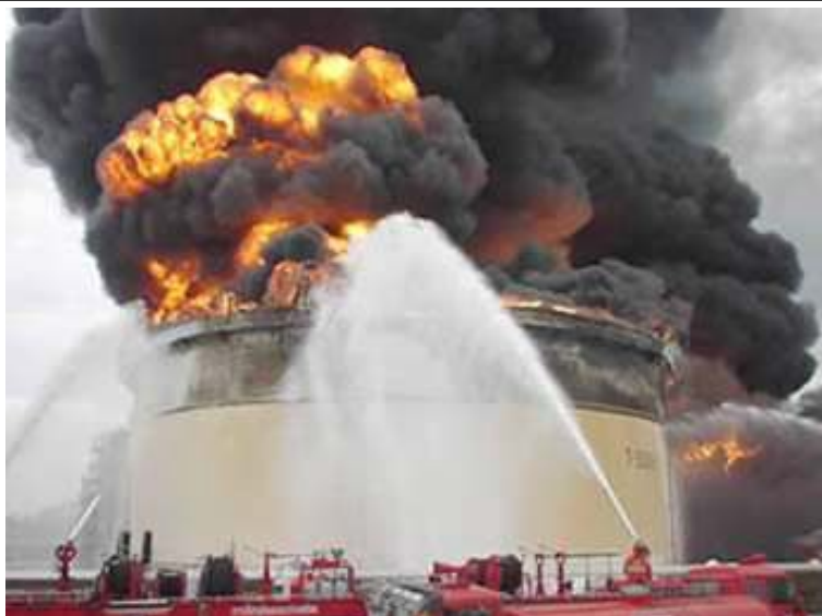
Ação de prevenção ao BLEVE
