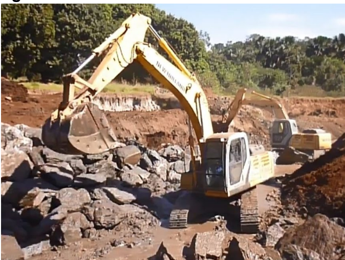
Figura 5 : Enrocamento de encostas
