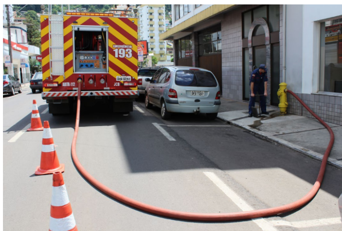
Figura 2 - Sistema de hidrante público
