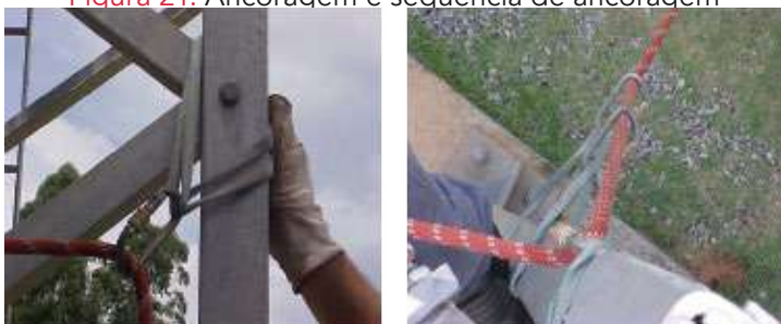
Figura 21. Ancoragem e sequência de ancoragem
