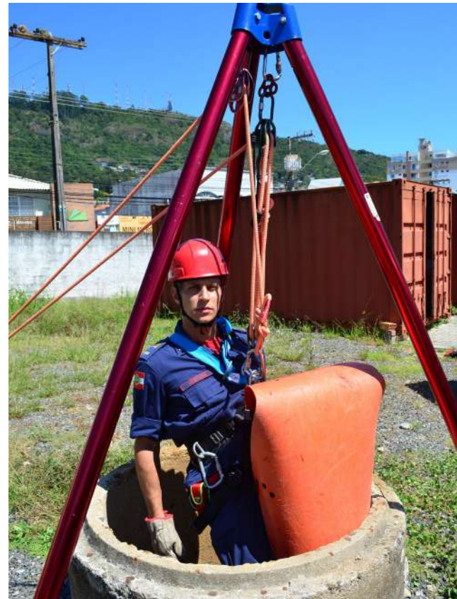
Figura 1. Tripé utilizado para resgate em poço
