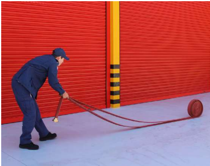
Figura 5 - Lançamento de conexões
