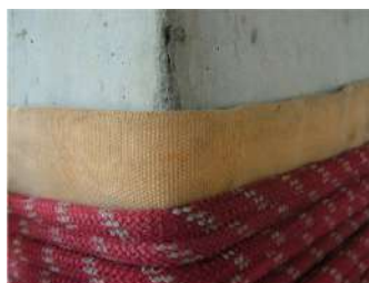
Proteção de mangueira
