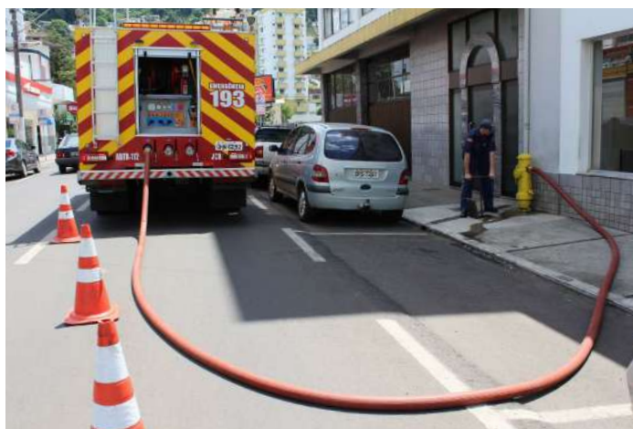
Figura 2 - Sistema de hidrante público
