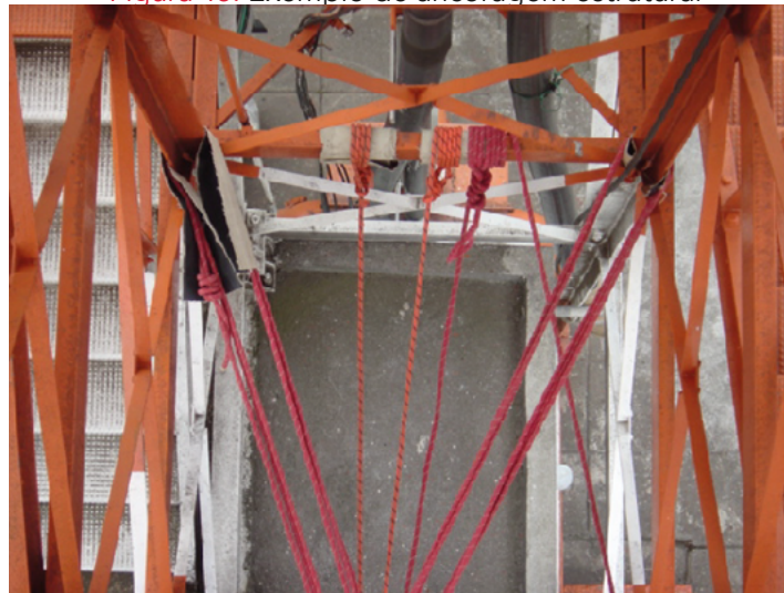
Figura 15. Exemplo de ancoragem estrutural
