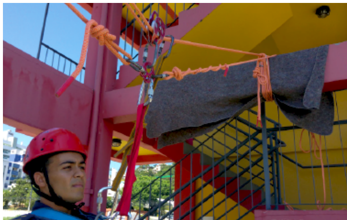
Figura 8. Sistema vai-e-vem mostrando a ancoragem da travessia
