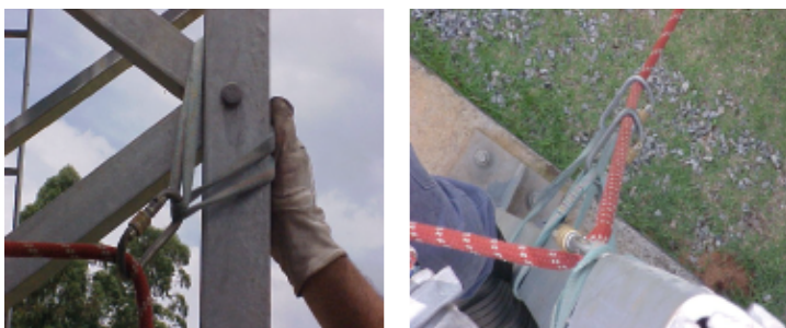
Figura 21. Ancoragem e sequência de ancoragem
