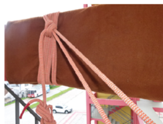
Tubo de mangueira com cobertor
