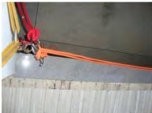
FIG 58 – Sistema com tração insuficiente e pouco espaço para realizar o tracionamento
