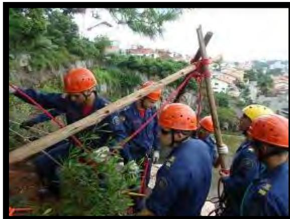
Figura 31 - Tripé montado na borda da pedreira
