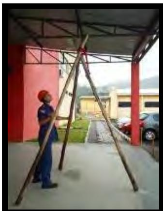
Figura 9 - Formando com a base um triângulo equilátero
