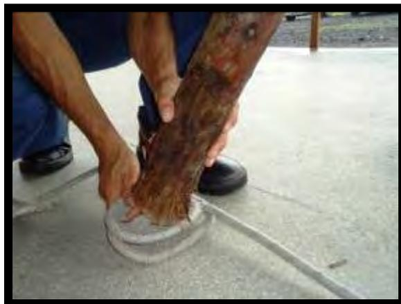
Figura 13 - Colocação da volta do fiel na haste
