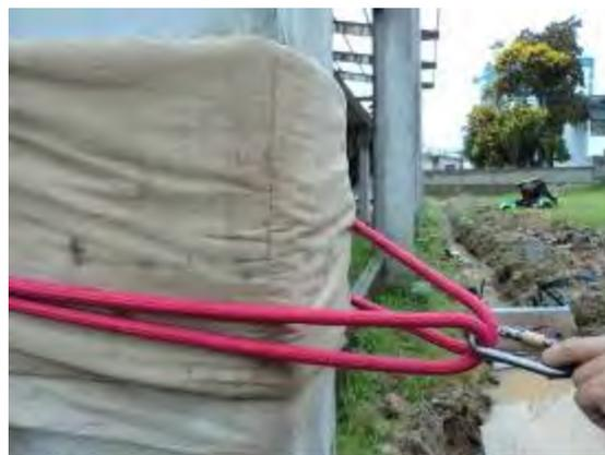
FIG 24 – Ponto fixo pronto utilizando cabo solteiro
