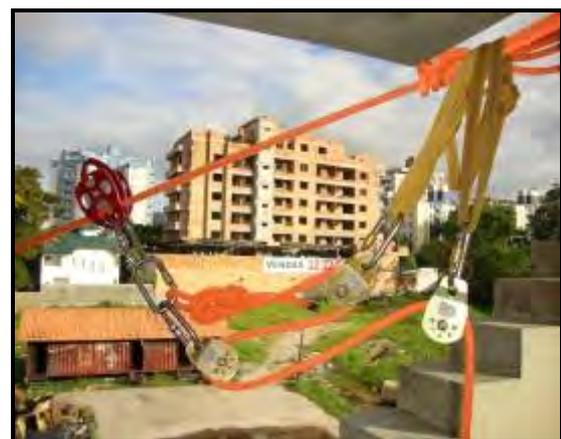
Novamente passe outra fita tubular dupla pelo nó de ancoragem do sistema de tirolesa. Passe a continuidade do cabo guia por uma roldana simples e clipe um mosquetão oval. Clipe o mosquetão da roldana na fita tubular dupla. Sistema 3:1 estendido pronto.
