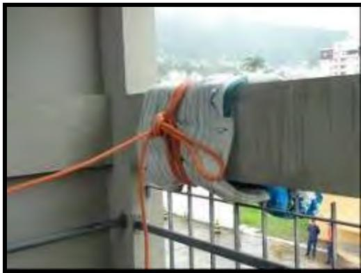
Fig. 1 - Ancoragem em um ponto "bomba" acima de onde a vítima se encontra.
