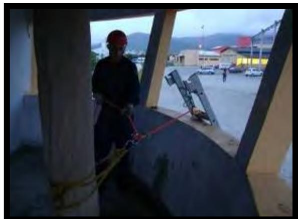
Foto 02 - Fixação de polia para mudança de direção. E proteção no 1º degrau da escada após a polia.
