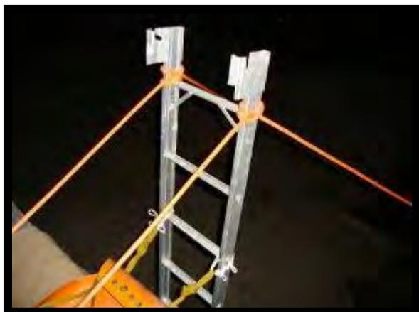
Foto 01 - Amarração da escada após posicionada próximo da edificação
