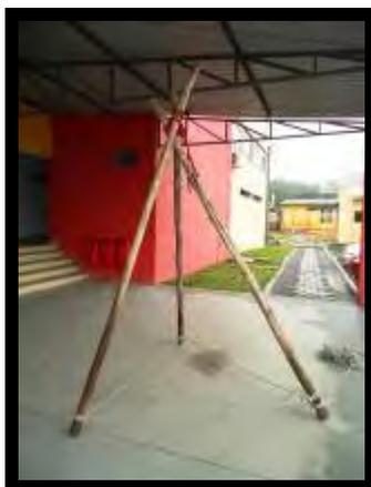
Figura 16 - Tripé pronto para receber o sistema de multiplicação de força
