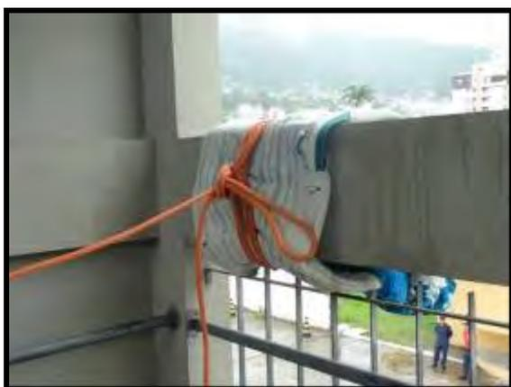
Fig. 31 – Ancoragem em um ponto “bomba”.
