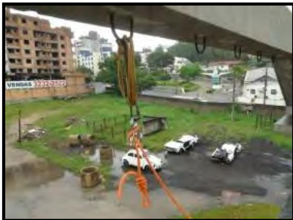
Fig. 40 – Técnica 1 (Ancoragem em um ponto fixo da edificação).
