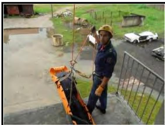
Fig. 17 – Fixação do bombeiro e vítima ao sistema.
