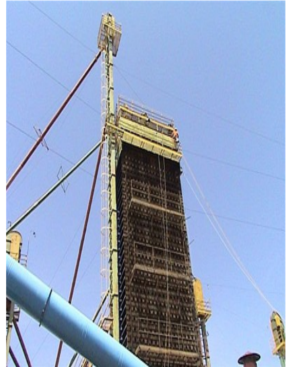
Foto 15 - Vista interna do Secador
