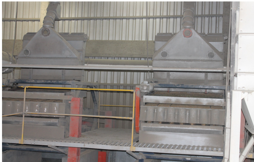
Foto 40 – Máquinas de limpeza de circuito aberto em operação (produção de pó)
