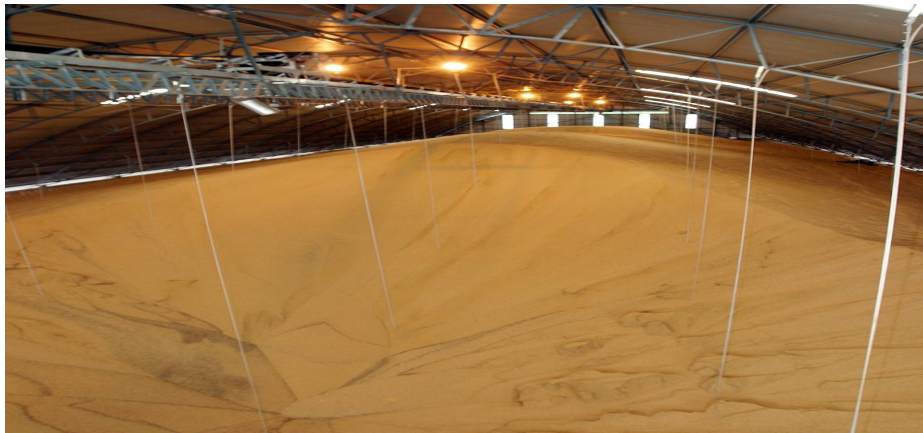
Foto 4 - Armazém fundo V – com detalhe de cabeamento da termometria
