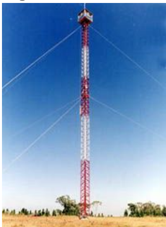
Figura 7: Torre de Observação
