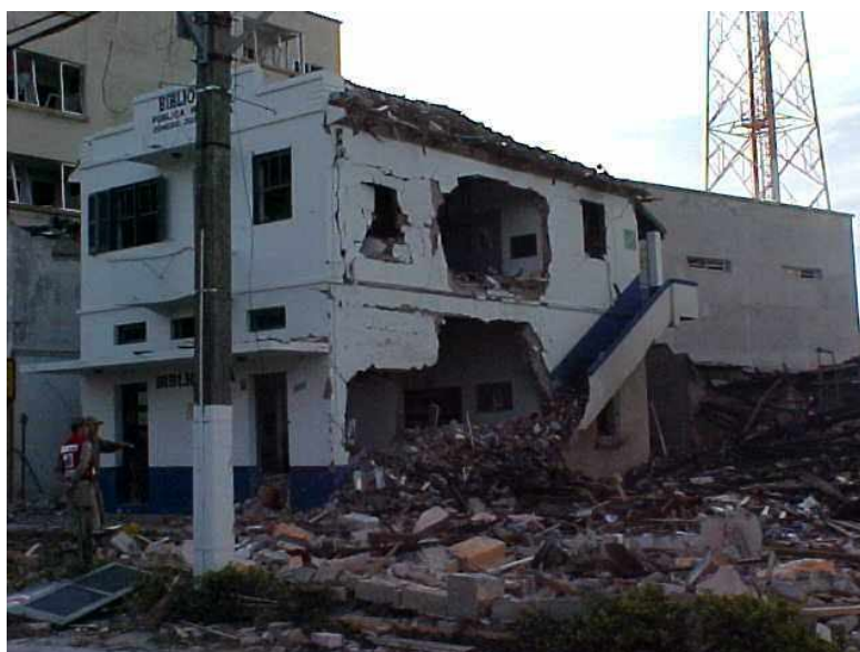
Figura 6 – foto de explosão seguida de incêndio na cidade de Sombrio em Santa Catarina, em data de 16 de agosto de 2004
