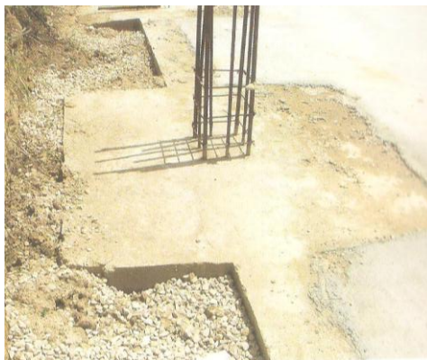
Figura 16- sapata em concreto armado
