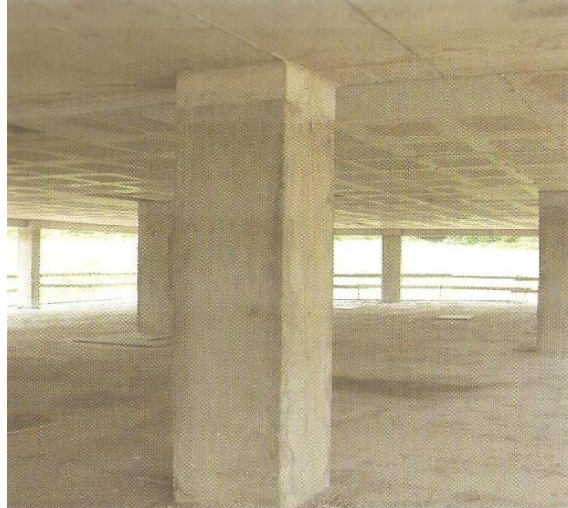
Figura 14- Laje descarregando num pilar
