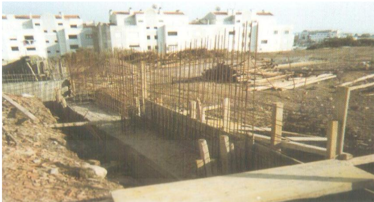
Figura 20- muro em construção
