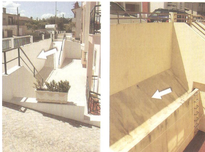
Figura 15-Muros de suporte em concreto armado
