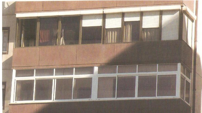
Figura 11- Varanda fechada com divisórias de alumínio
