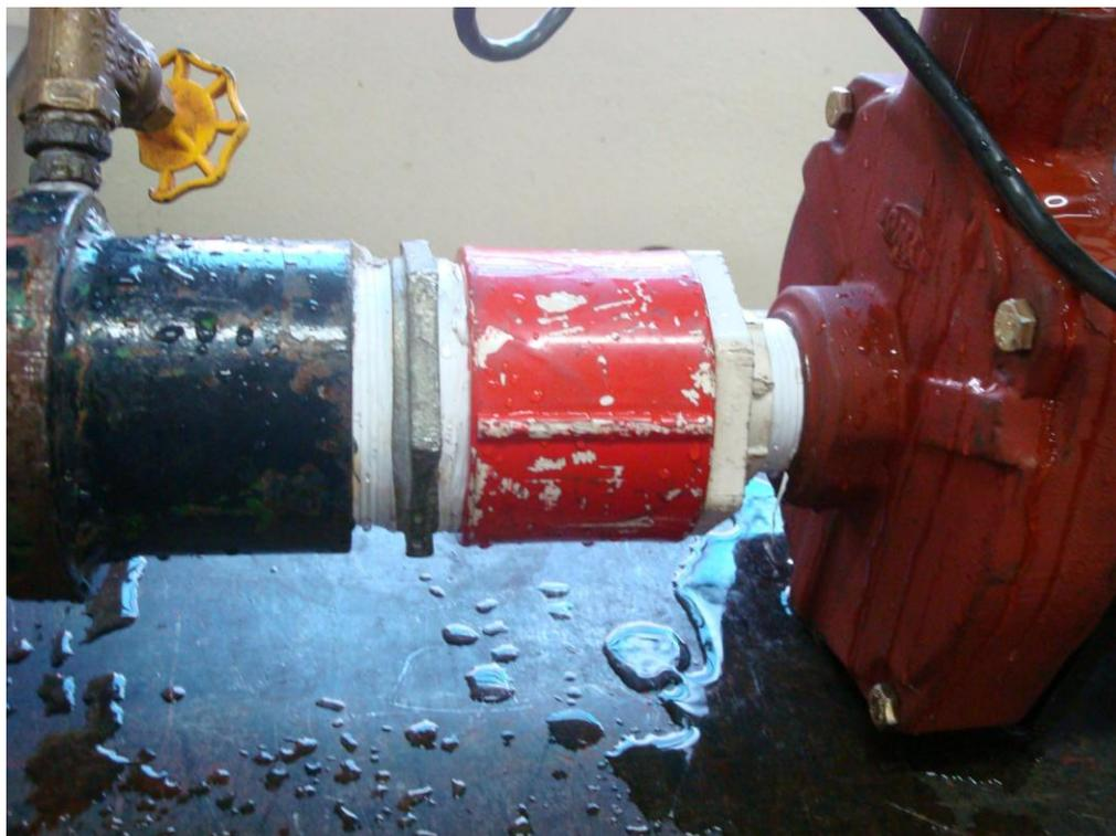
Adaptador de 2 ½" de plástico acoplado na bitola original da bomba
