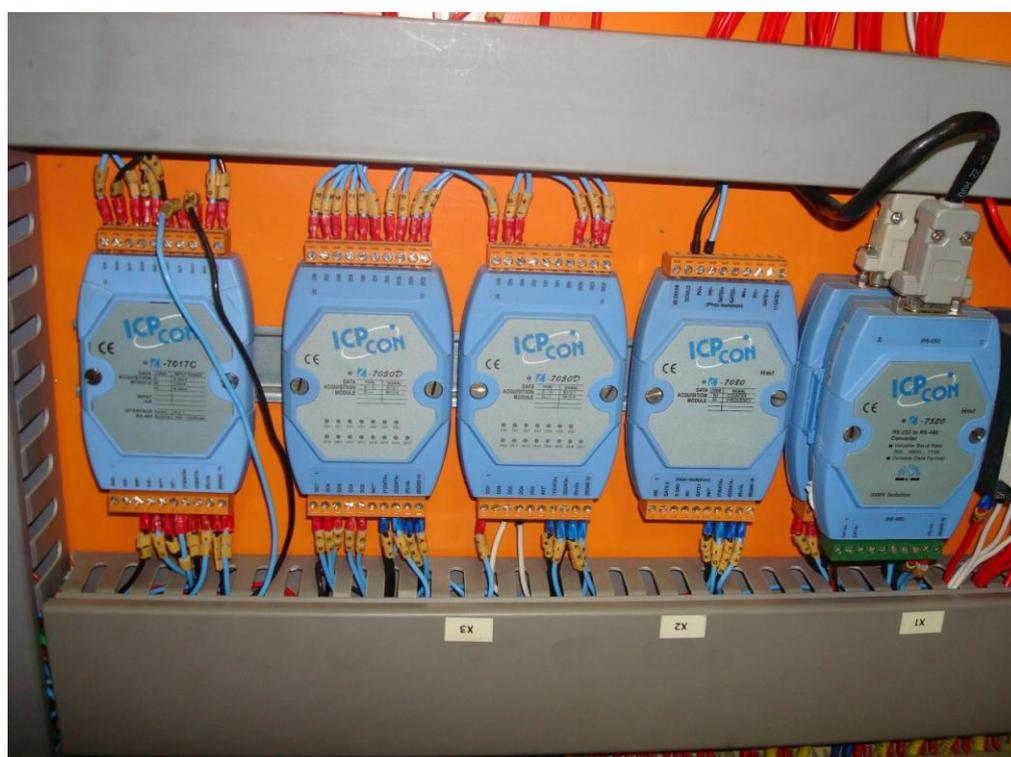
Módulos eletrônicos para aquisição de dados
