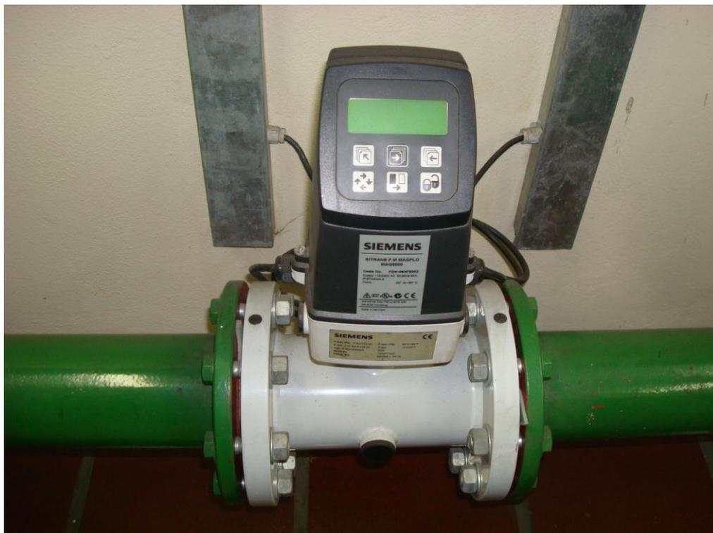
Medidor de vazão
