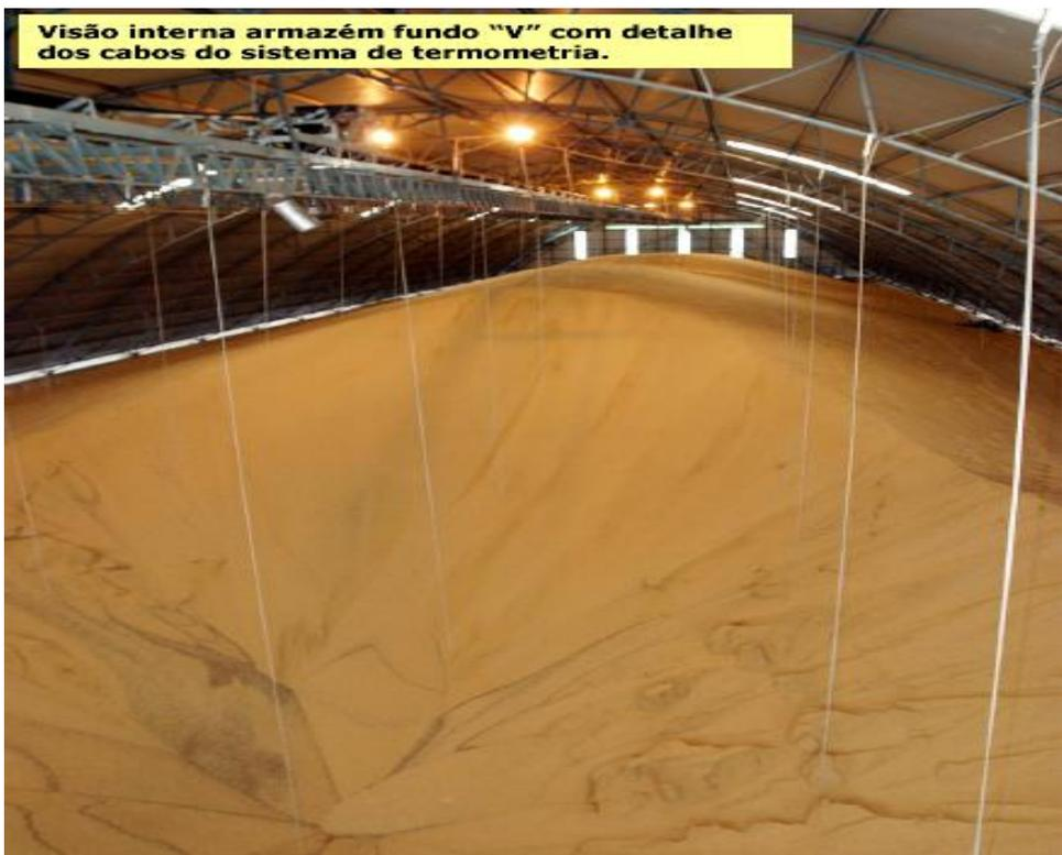
Visão interna armazém fundo "V" com detalhe dos cabos do sistema de termometria.
