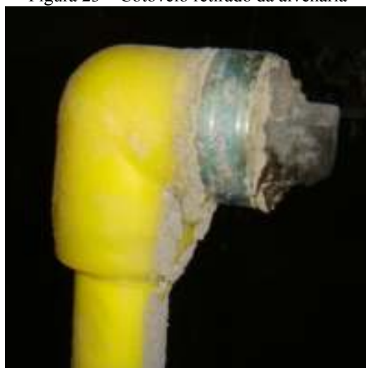
Figura 23 – Cotovelo retirado da alvenaria
