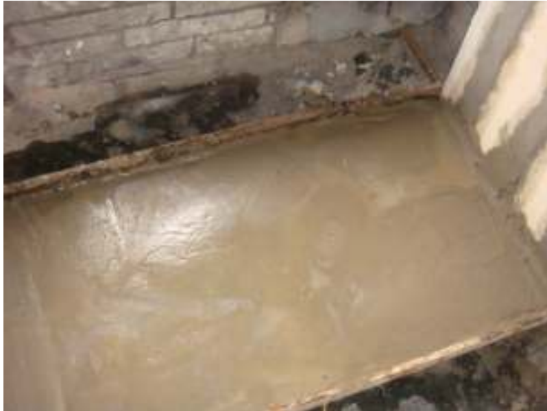
Figura 18 – Trecho horizontal da segunda variação sendo coberto
