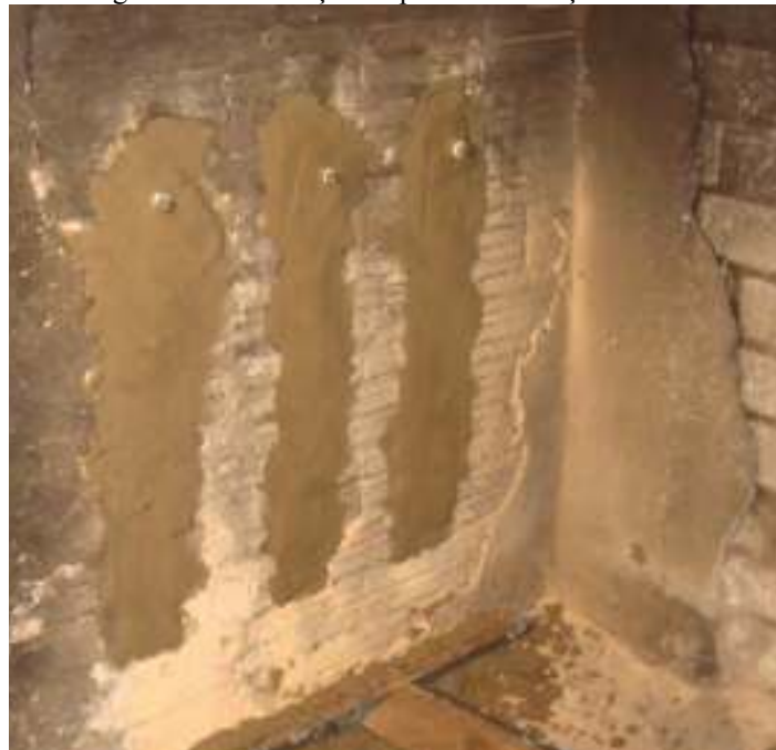
Figura 14 – Tubulação da primeira variação coberta
