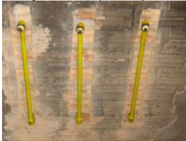
Figura 13 – Tubulação parcialmente pronta.
