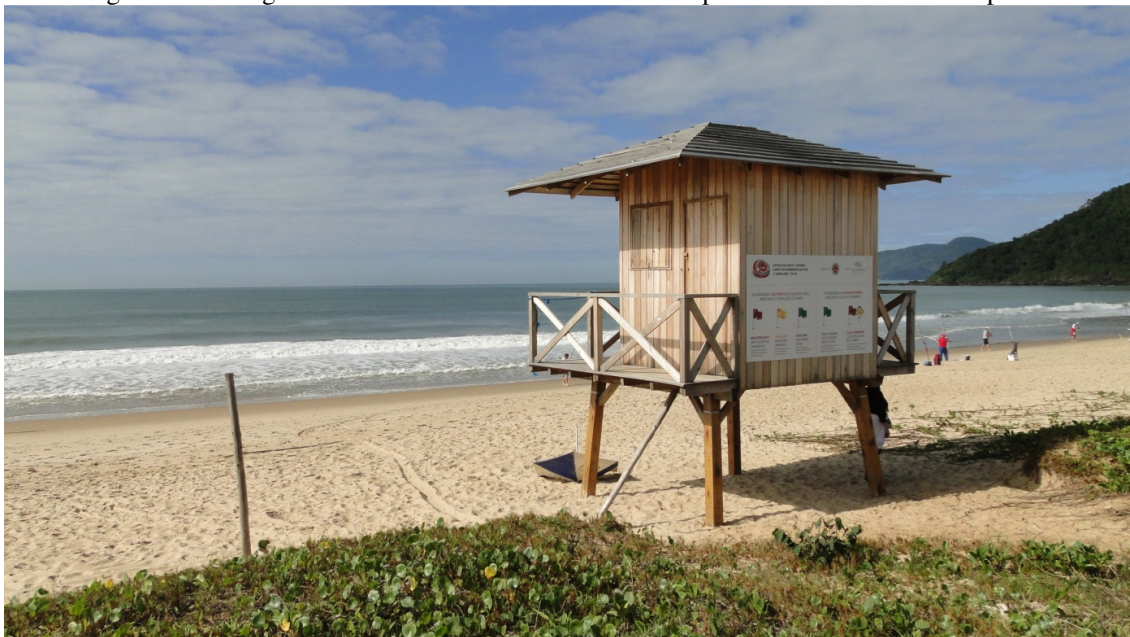
Figura 3 - Posto guarda-vidas com estrutura de madeira e placa informativa atrás do posto
