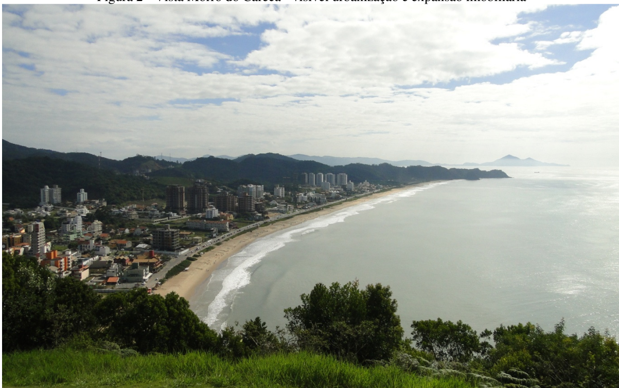
Figura 2 - Vista Morro do Careca - visível urbanização e expansão imobiliária
